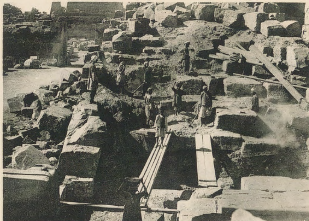
1. — Enlèvement du massif du III e pylône, 12 mars 1923.
